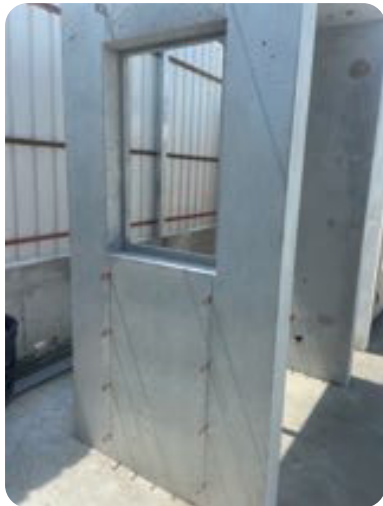
拆模後完成面
