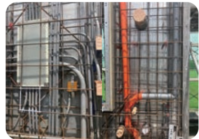
水電配管完成
