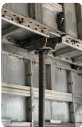
模板支撐頭組裝完成
