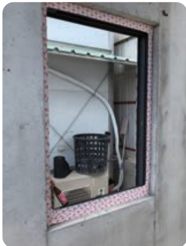
企口施座 + 窗戶安裝
