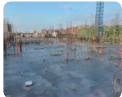
混凝土澆置粉光完成
