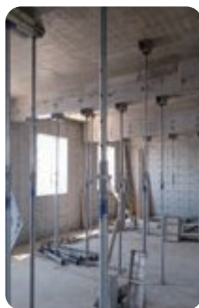
模板卸除後、 支撐頭留在原地
