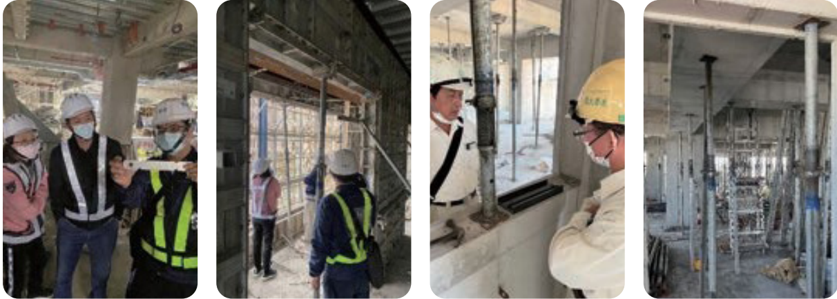
2021 參訪雙喜營造廣慈社宅 C 標工地
